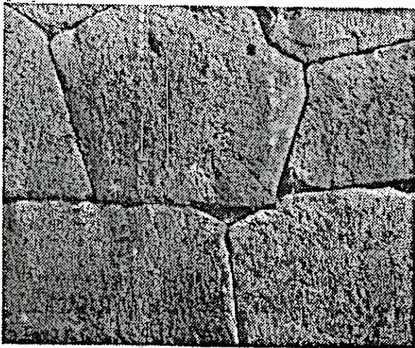
Le mura prima del restauro
