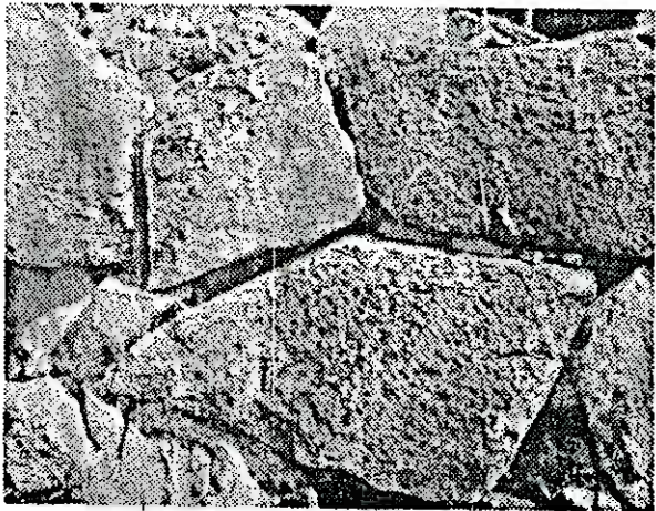
Le mura dopo il restauro
