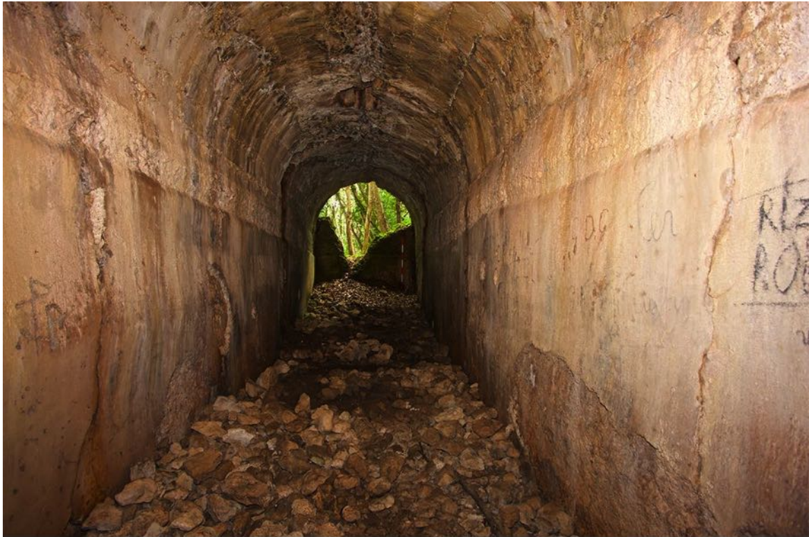
(Fig. 19) Interno cisterna villa “Grotta della Sibilla”
