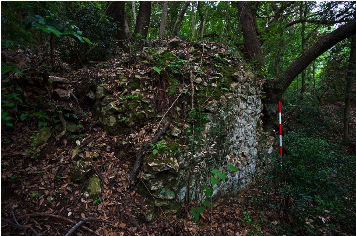
(Fig. 18) Muro della sostruzione interna villa “Grotta della Sibilla”
