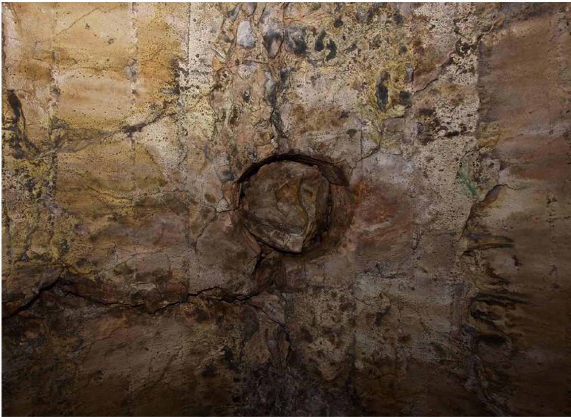
(Fig. 21) Foro di immisione dell'acqua sulla volta della cisterna
