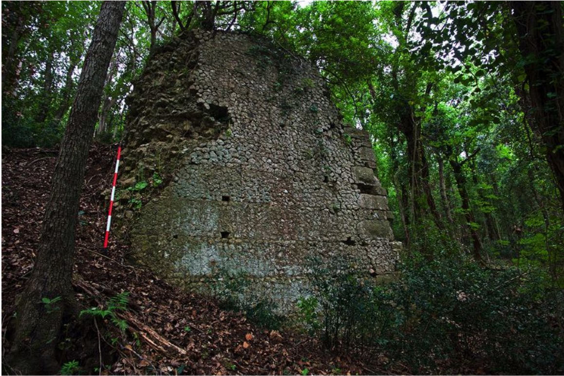
(Fig. 17) Muro con rastremazioni ad angolo N-O villa “Grotta della Sibilla”
