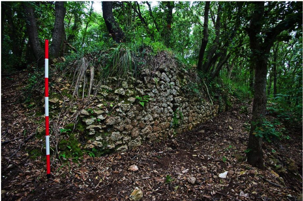
(Fig. 4) Muro di terrazzamento N-E villa “Grotta del Peretto”
