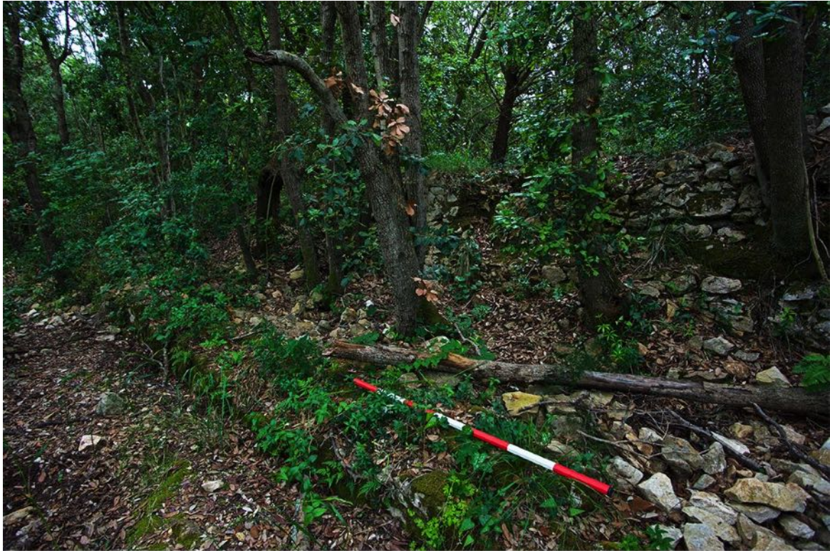
(Fig. 5) Muro di terrazzamento N-O villa “Grotta del Peretto”
